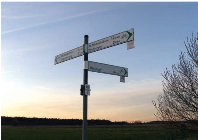
Abbildung 8: Anbringung von Einschubschildern am Armwegweiser
