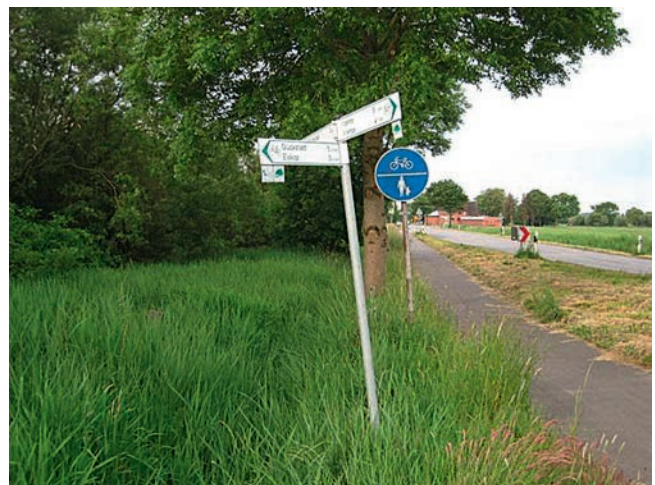
Abbildung 38: Mast auf Grund von fehlender Verankerung schief
