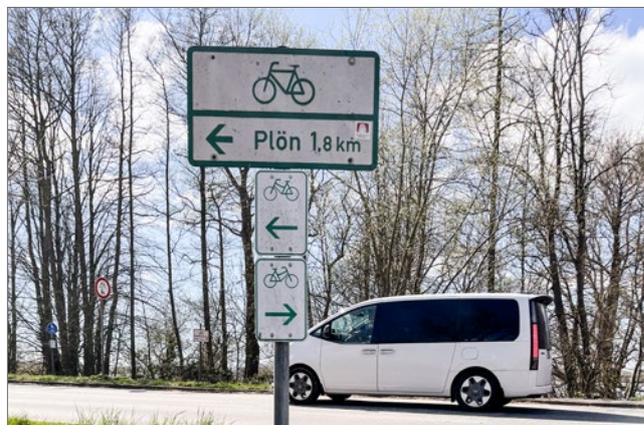
Abb. 8.0.0.6. Nicht erlaubte Montage von Ziel- und Zwischenwegweisern an einem Standpunkt
