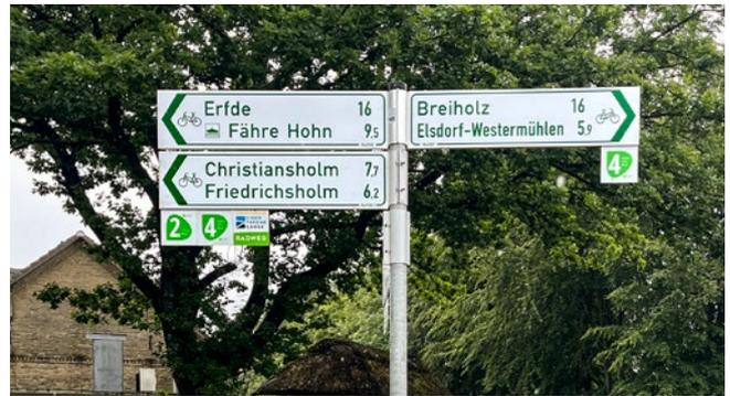
Abb. 4.1.0.1. Armwegweiser mit Einschubschild
